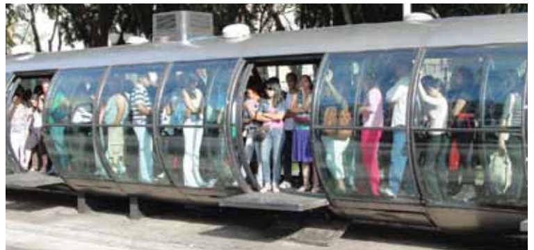
Porta automática em uma estação BRT em Curitiba. As portas estão abertas, embora não haja nenhum ônibus na estação. Isto é um risco numa estação lotada, já que os passageiros podem cair acidentalmente nas faixas de ônibus. Foto cortesia da EMBARQ Brasil.
