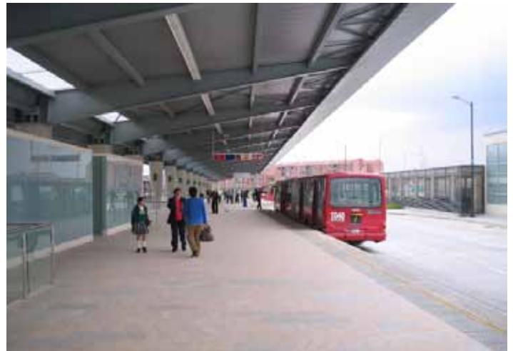
Imagens mostrando o layout típico dos terminais do TransMilenio. Acima: a parada de ônibus alimentador (ônibus convencionais) no lado esquerdo da plataforma. Abaixo: os ônibus da linha troncal (ônibus articulados) param no lado direito da mesma plataforma. Fotos EMBARQ.
