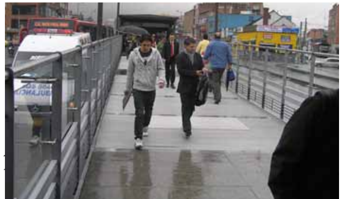
TransMilenio 2011: os gradis ao longo desta ligação foram elevados para que seja mais difícil escalá-los. Recomenda-se este tipo de gradil mais alto em trechos que conectem diferentes partes de uma mesma estação. Foto EMBARQ.
